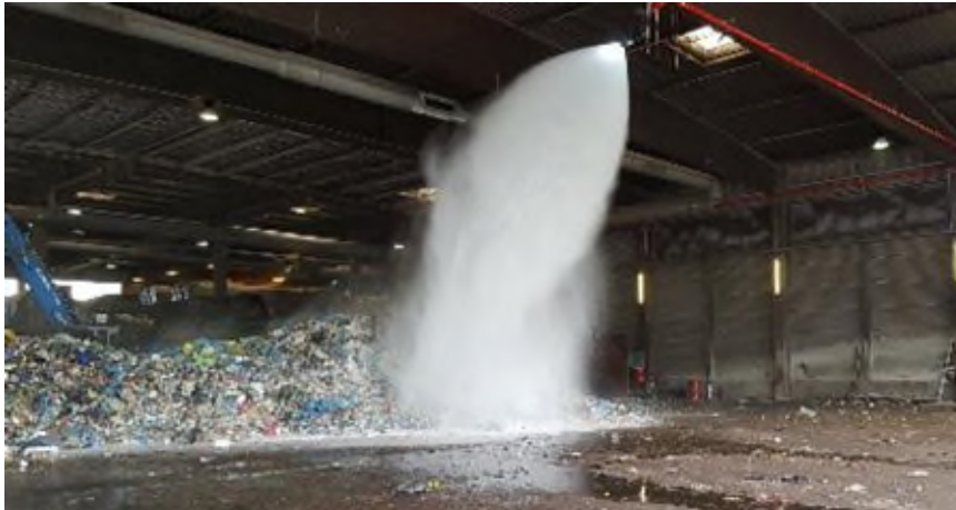
Abb. 17 Demonstration einer stationären Löschanlage im Flachbunker
