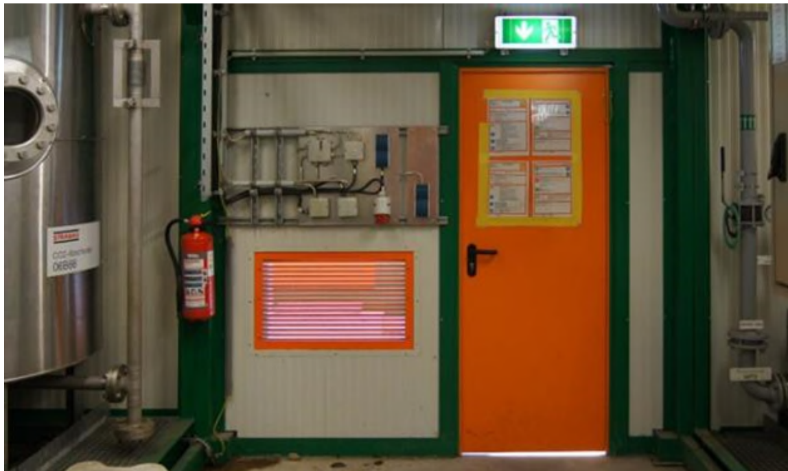
Abb. 4 Betriebsanweisungen an gut sichtbarer Stelle (AUSTAUSCHEN!, Betriebsanweisungen kaum erkennbar)
