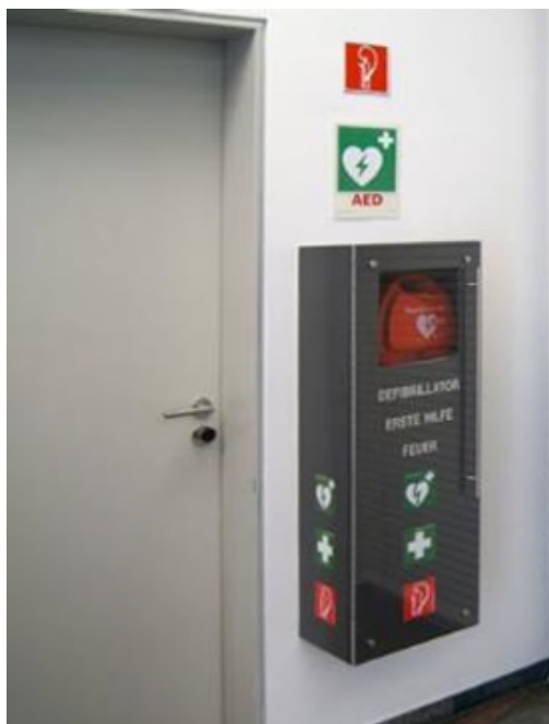
Abb. 1 Vor rauen Einflüssen geschützte Notfallsäule (mit Defibrillator, Erste-Hilfe-Material und Feuerlöscher) AUSTAUSCHEN (Piktogramme veraltet)
