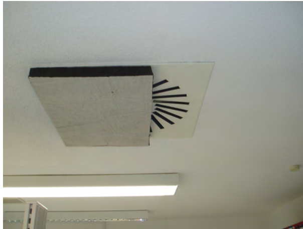
Abbildung L.4: Einschränkung der Zuluftöffnungen
