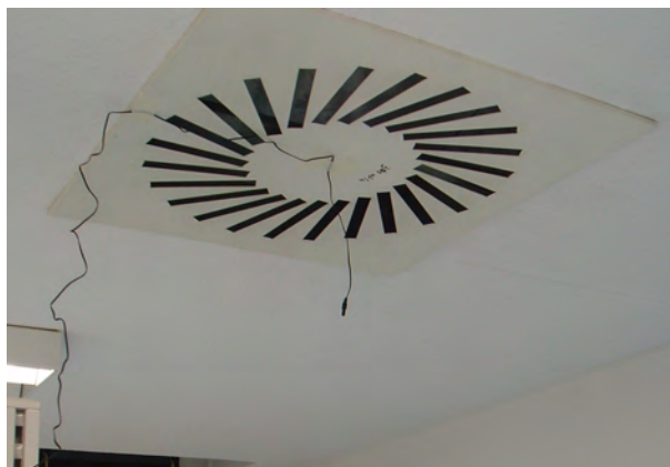
Abbildung L.3: Auslassöffnung Zuluft ohne Drallkörper, Installation zur Messung der Zulufttemperatur
