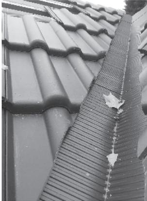
**Bild 1.** Dachkehle mit geschnittenen Dachsteinen.
