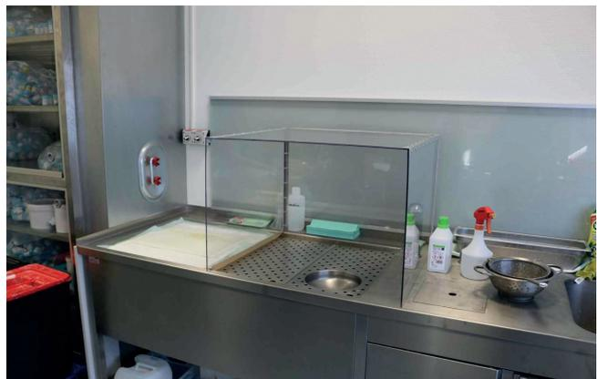
**Bild** Im IFA hergestellte Erfassungshaube über der Lochblechabsaugung eines Pathologisches. Foto: W. Wegscheider
