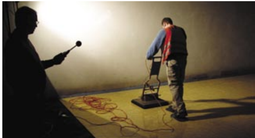
Abbildung 10: Geräuschmessungen beim Einsatz eines Fliesenklebers (Rollenvibrators).
