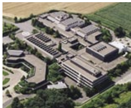
Abbildung 4: Gebäude des BGIA in Sankt Augustin.
