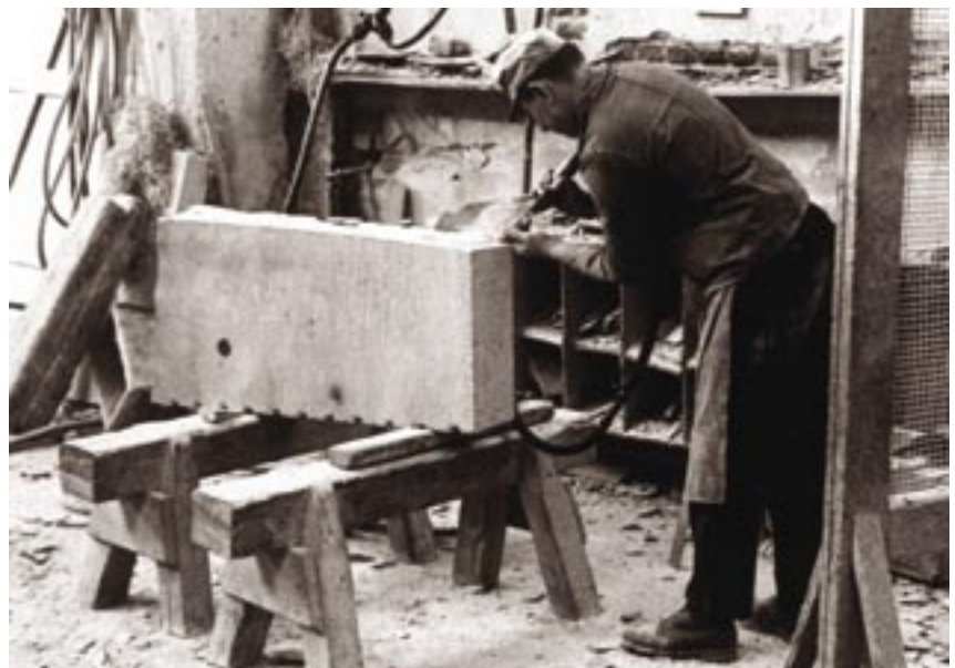
Abbildung 7: Steinmetzarbeiten in den 1960er-Jahren.
