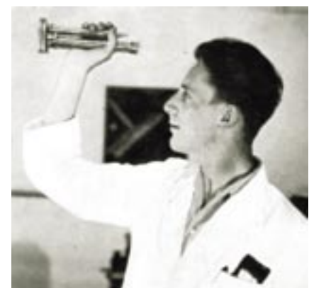
Abbildung 9: Konimeter zur direkten Messung der Staubbelastung in der Atemluft.
