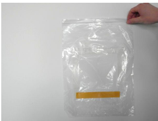
Abb. 3: Schleuse mit dem Verschluss nach oben auf die Wand kleben.
