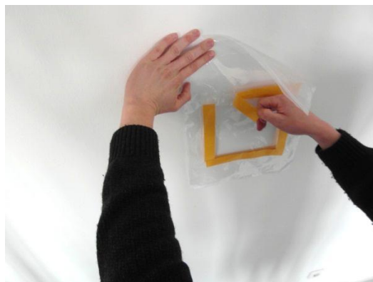
Abb. 2: Schutzfolie des doppelseitigen Klebbands auf der Rückseite der Schleuse entfernen.
