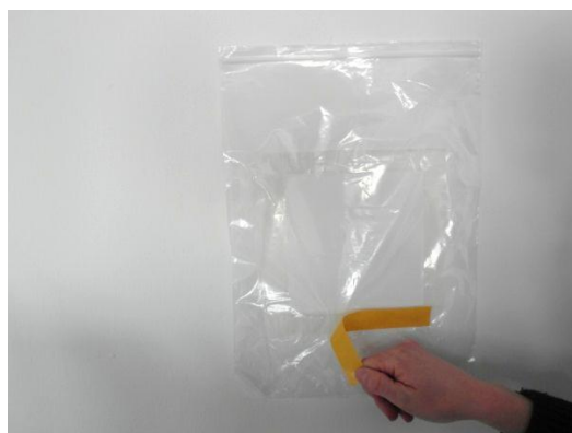
Abb. 4: Schutzfolie des doppelseitigen Klebbands auf der Vorderseite der Schleuse abziehen.
