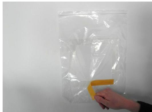
Abb. 4: Schutzfolie des doppelseitigen Klebbandes auf der Vorderseite der Schleuse abziehen
