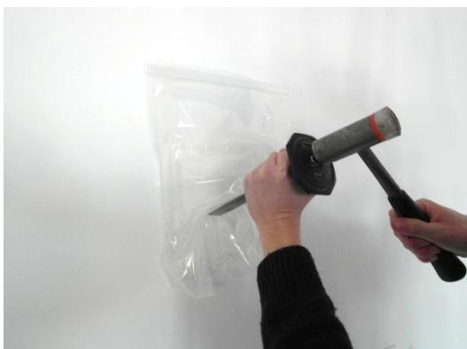
Abb. 5: Flachmeißel auf das doppelseitige Klebeband setzen und Wandbekleidung durch die Schleuse ausstemmen
