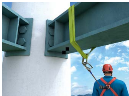
Abb. 5: Anschlagmöglichkeit Stahlträger
