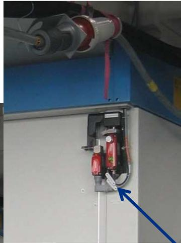
zusätzlicher Sicherheitsschalter direkt in Steuerung Brandmeldezentrale integriert
