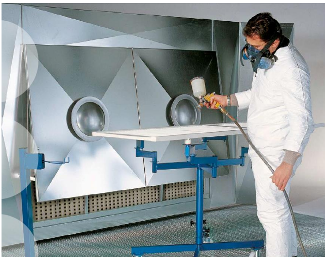
Bild 1: Manuelles Spritzlackieren an einer Absaugwand mit Trockenabscheidung
