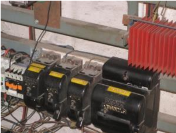
Bild 12: Asbesthaltige Leichtbauplatte (heller Hintergrund) bzw. asbesthaltige Pappe hinter Schaltelementen
