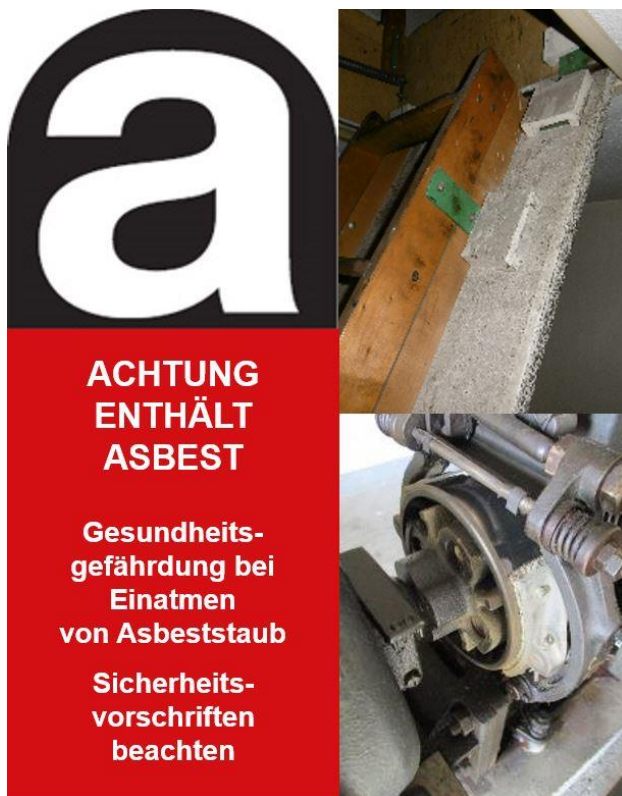
Bild 1: Asbestwarnung, Lukendeckel mit beplankter asbesthaltiger Leichtbauplatte, asbesthaltiger Bremsbelag
