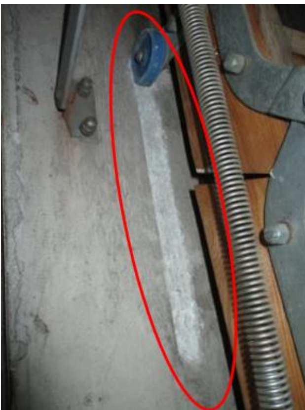
Bild 4: Faserfreisetzung infolge Abrieb durch die Führungsrolle auf dem Lukendeckel
