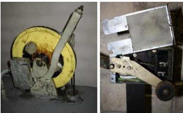
Bild 12: Asbesthaltige Leichtbauplatte (heller Hintergrund) bzw. asbesthaltige Pappe hinter Schaltelementen
