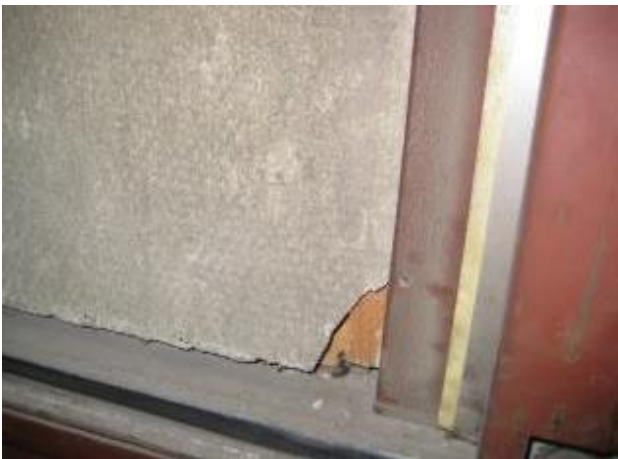
Bild 7: Asbestzementplatten als Wandverkleidung
