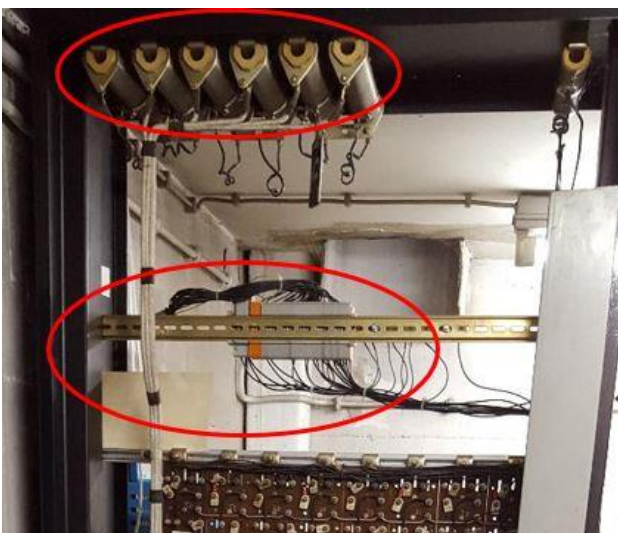
Bild 14: Drahtummantelung (zu Leistungswiderständen)
