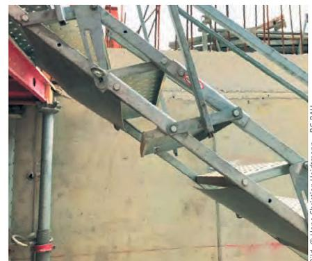
Treppe mit nivellierbaren Stufen im Montagezustand, durch Anbauteile verlängerbar
