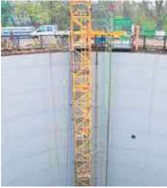
Abb. 10: Kranturm als Leitertaufstieg
