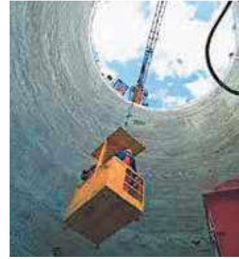
Abb. 12: Einsatz eines Arbeitskorbes für den Personentransport
