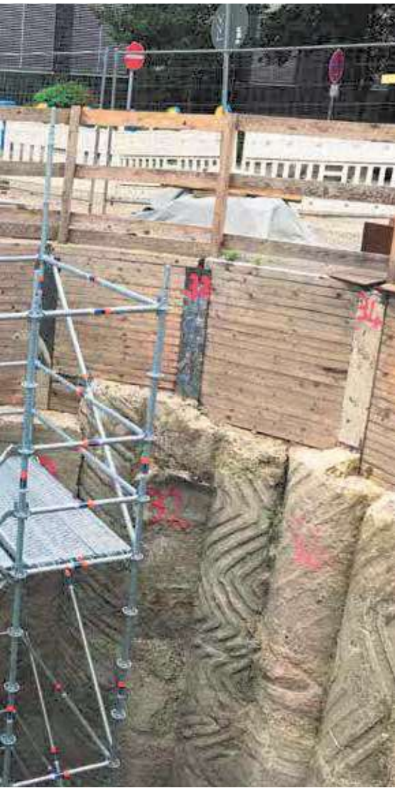
Abb. 1: Beispiel für einen Treppenturm mit breiten Stufen
