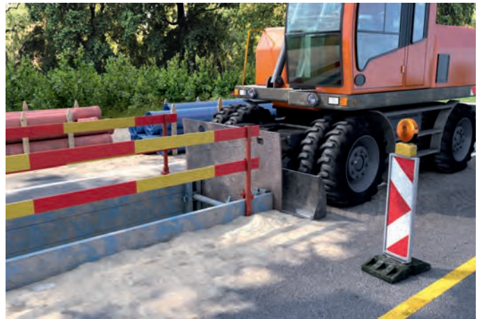
Abb. 10: Stirnseitiger Verbau mit Stahlplatte und Absturzicherung während Arbeitspause
