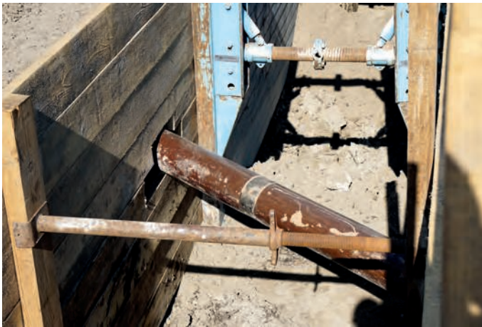
Abb. 9: Kreuzende Leitung, mit waagerechtem Verbau eingefasst
