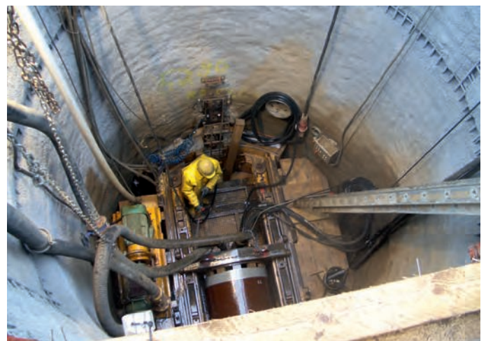
Abb. 3: Startbaugrube für einen Rohrvortrieb ohne ausreichenden Platz für einen Treppenturm
