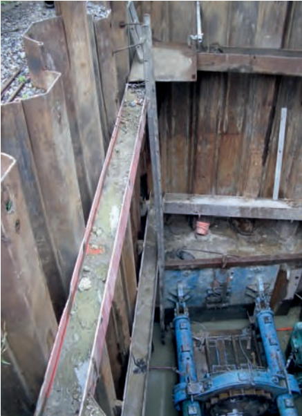
Abb. 4: Startgrube für Rohrvortrieb, Zugang über Steigleiter hier nur unter Verwendung von PSAgA möglich (Pressgrube)
