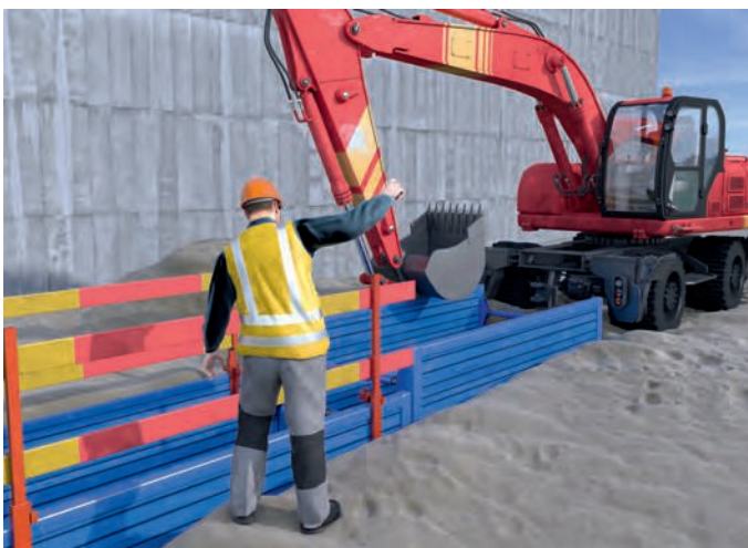
Abb. 13: Absturzsicherung am Verbau bei Baggerarbeiten am Graben
