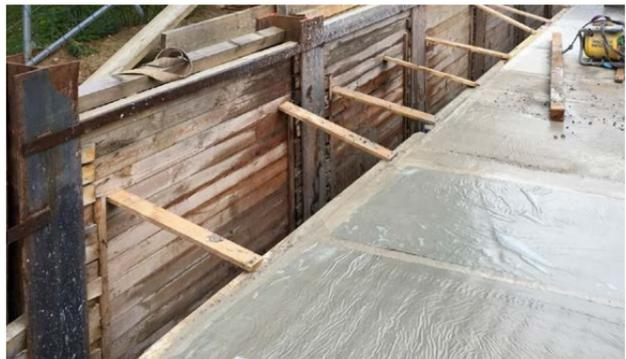
Ist genügend Arbeitsraum zum Rückbau des Trägerbohlverbau vorhanden und wie sieht es mit der Absturzsicherung aus?
