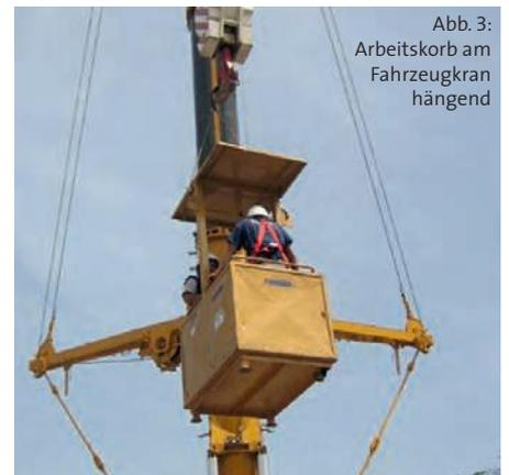
Abb. 3: Arbeitskorb am Fahrzeugkran hängend
