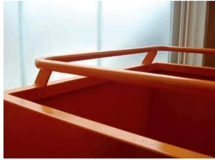
Abb. 10: Handlauf zur Vermeidung von Quetschgefahren
