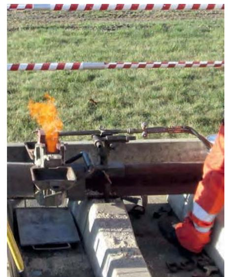
speziellen Brenner über eine vorgegebene Zeit vorgewärmt. Der Brenner wird i.d.R. mit Propangas betrieben, das aus der gasförmigen Phase der Gasflasche entnommen wird.
