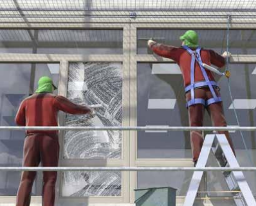
Absturzkanten und sich selbst sichern.
