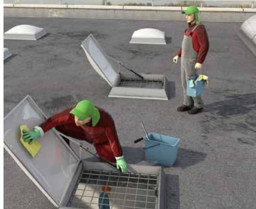
Bei Lichtkuppeln, Öffnungen und nicht durchbruch-sicheren Glasdächern gegen Absturz sichern.
