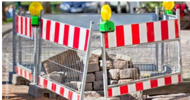
Abb. 3 Baustelle mit Barken und Lichtzeichen gesichert
