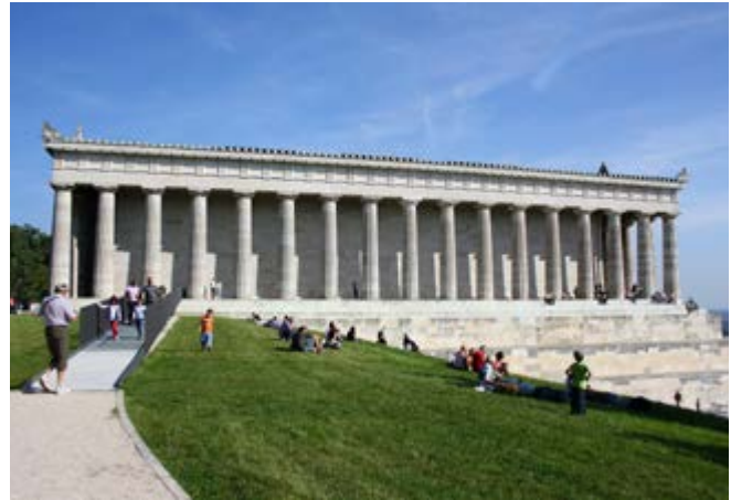
Abb. 1 Barrierefreier Zugang zu öffentlich zugänglichem Gebäude
