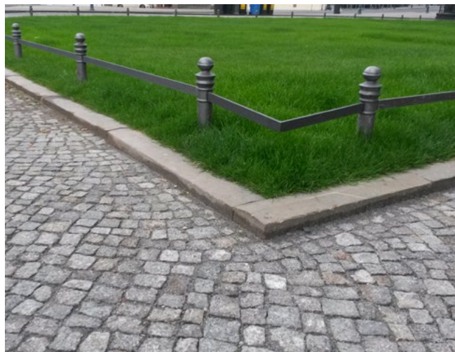
Abb. 6 Verkehrsflächenabgrenzung durch markante Aufkantung
