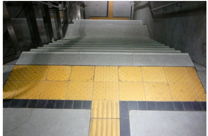
Abb. 11 Hinweis auf Gefahrenstelle
