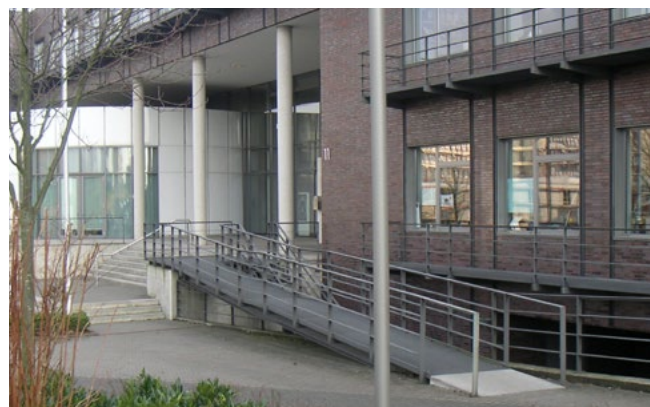
Abb. 4 Rampe im Außenbereich mit Gitterrostbelag
