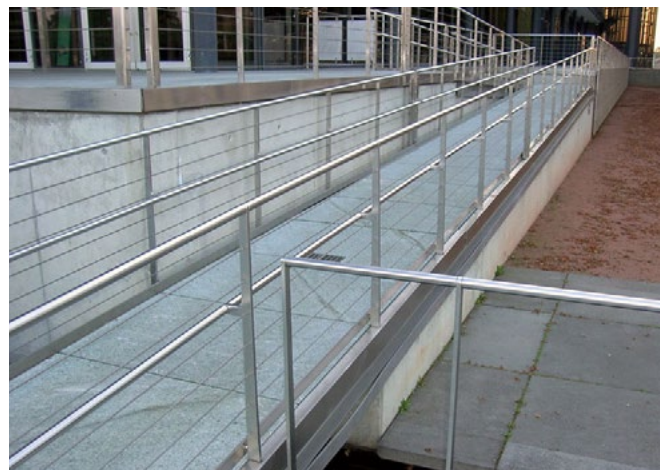
Abb. 7 Rampe im Außenbereich mit Betonplattenbelag
