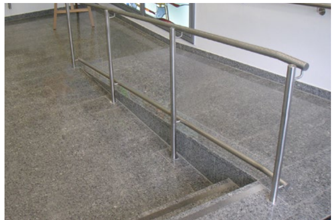
Abb. 1 Zwei Stufen mit alternativer Rampe
