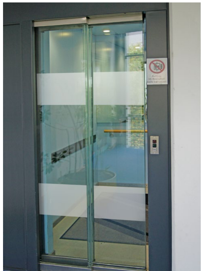
Abb. 1 Aufzug mit Markierungen auf Glasflächen
