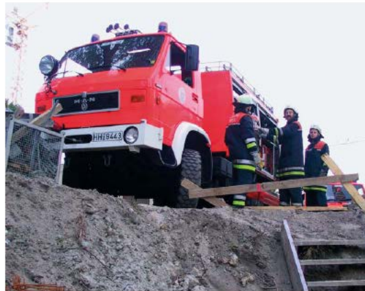
Das unmittelbar an der Baugrube aufgestellte Einsatzfahrzeug bildet eine unnötige und gefährliche Auflast für die Böschungskante.
