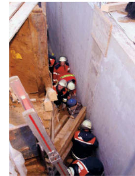
Schwer zugängliche Einsatzstelle. Der Zugang in dem engen Arbeitsraum der verbauten Baugrube ist nur mittels Leitern möglich.
