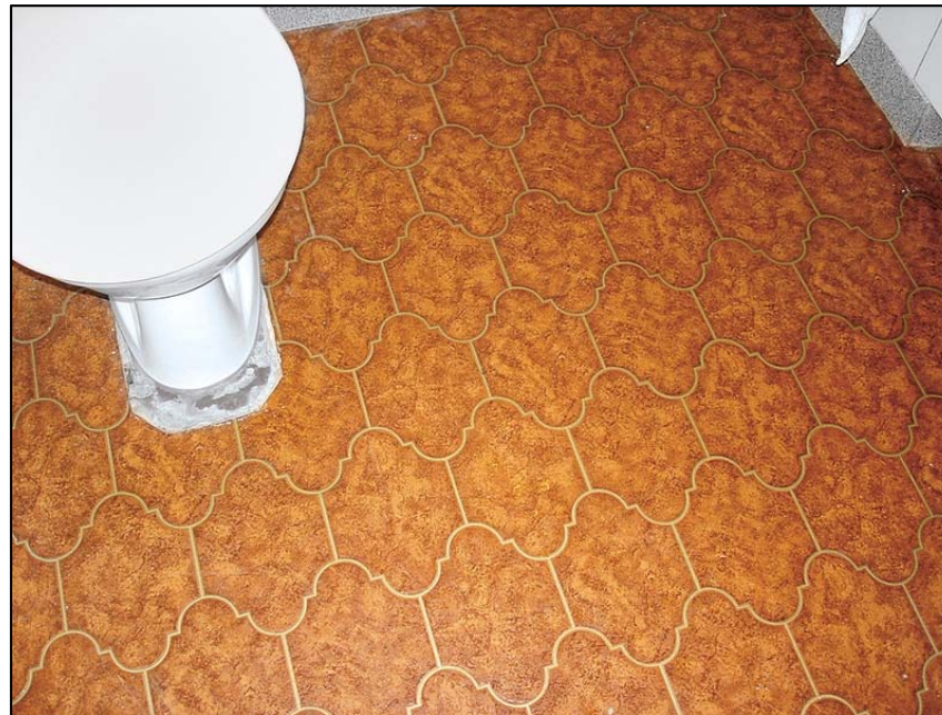
Entfernen von mehrschichtigen Bodenbelägen (Cushion-Vinyl)
