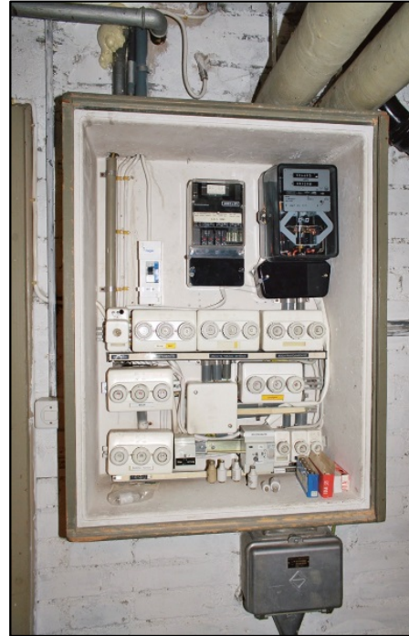
Zerstörungsfreie Demontage SGK
