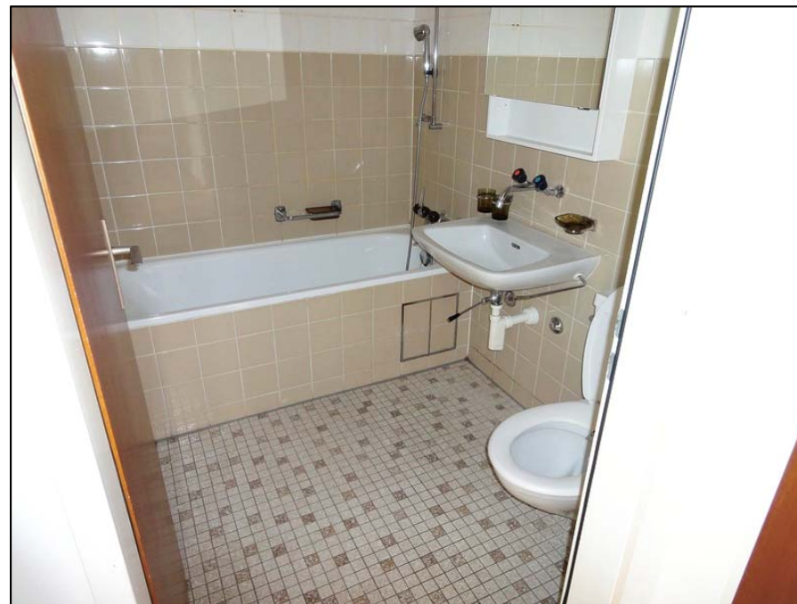
Entfernen von Fliesen(-kleber)
