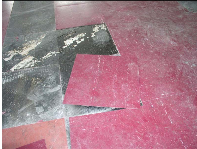
Entfernen von einschichtigen Bodenbelägen (Floor-Flex)
