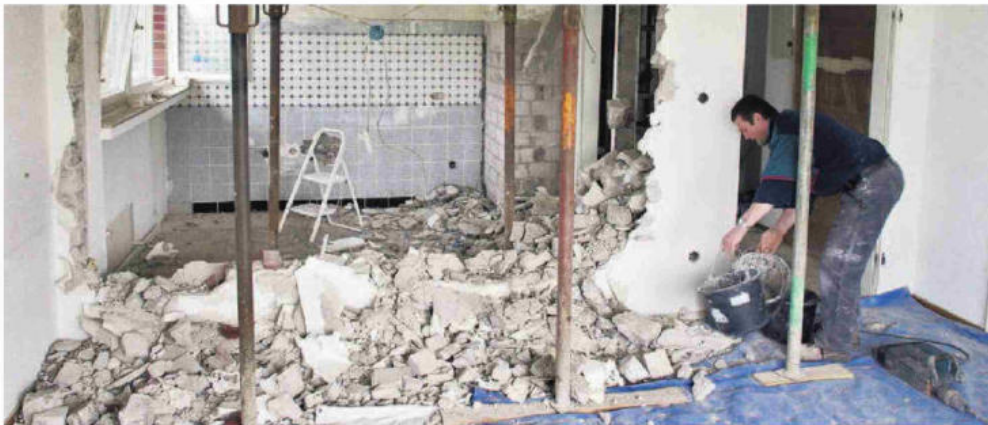
Vor allem bei Umbauten und Renovationen kommt oft Asbest zum Vorschein: In 95 Prozent aller Bauten in der Schweiz, die vor 1990 erstellt wurden, schimmert krebsregender Asbest. Bild: photothek
