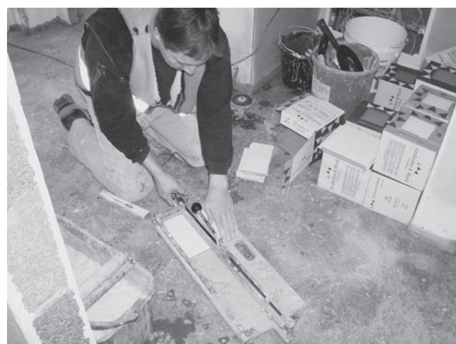
Abbildung A.14: Fliese mit Fliesenbrett schneiden
