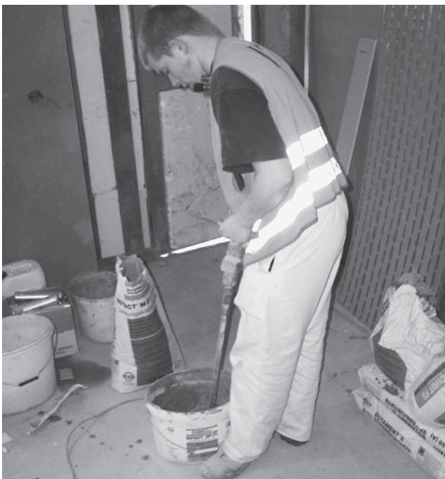
Abbildung A.19: Fliesenkleber anmischen
