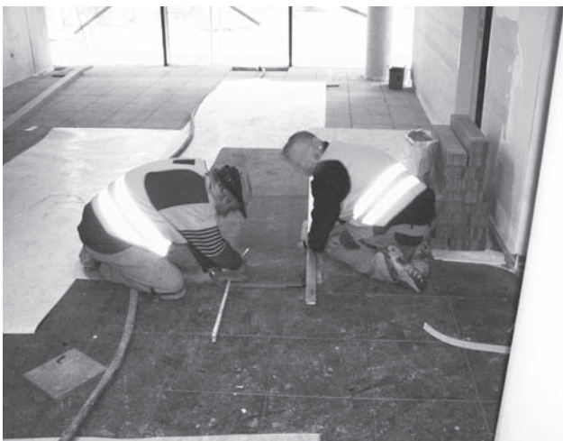
Abbildung A.37: Ausmessen und anzeichnen
