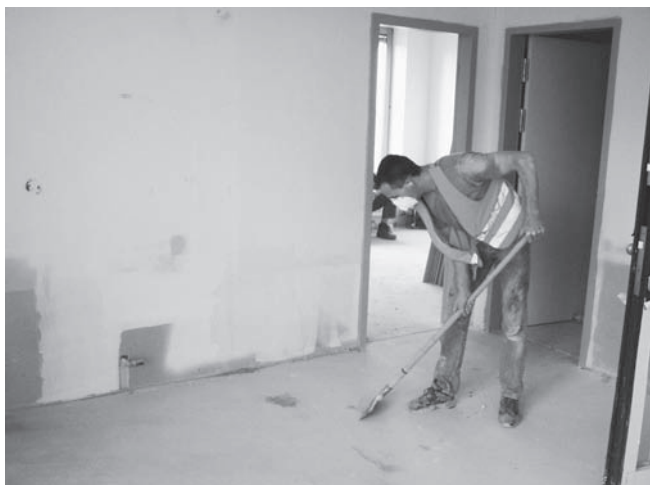
Abbildung C.7: Estrich mit Bodenstripper bearbeiten
