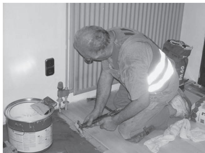
Abbildung B.7: Parkett verlegen
