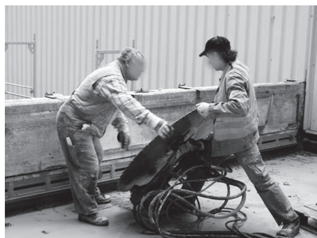
Abbildung D.22: Betonsäge montieren
