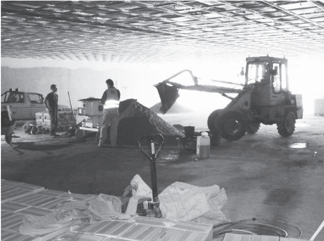
Abbildung A.5: Baustelle 11
