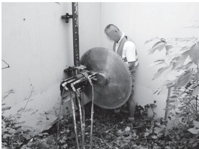
Abbildung D.12: Wandsäge montieren
