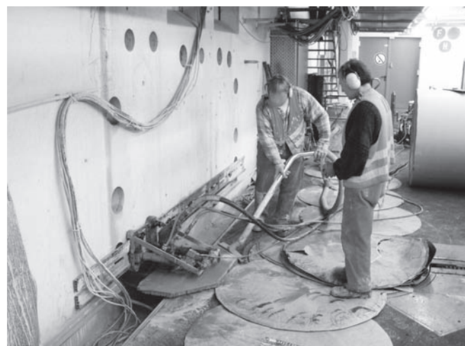
Abbildung D.19: Betonsäge bedienen
