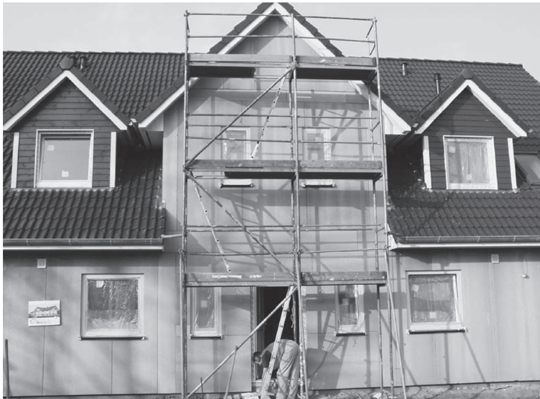
Abbildung A.4: Baustelle 8
