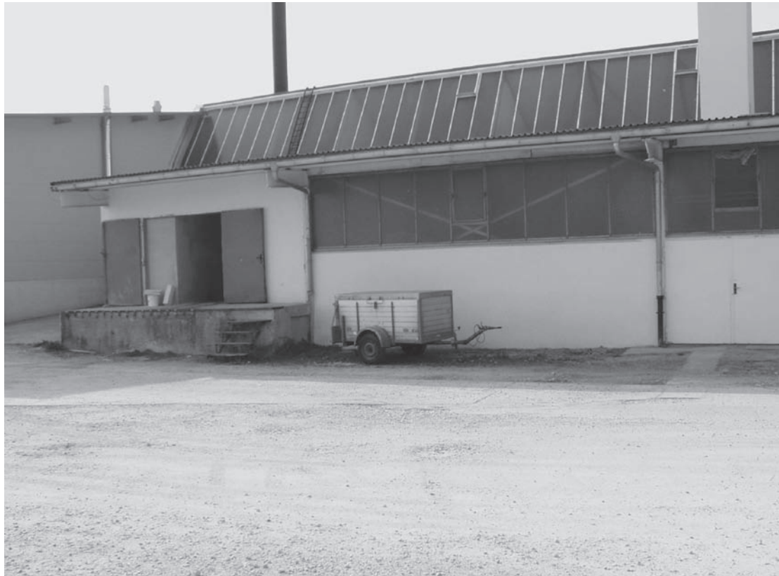
Abbildung A.6: Baustelle 12
