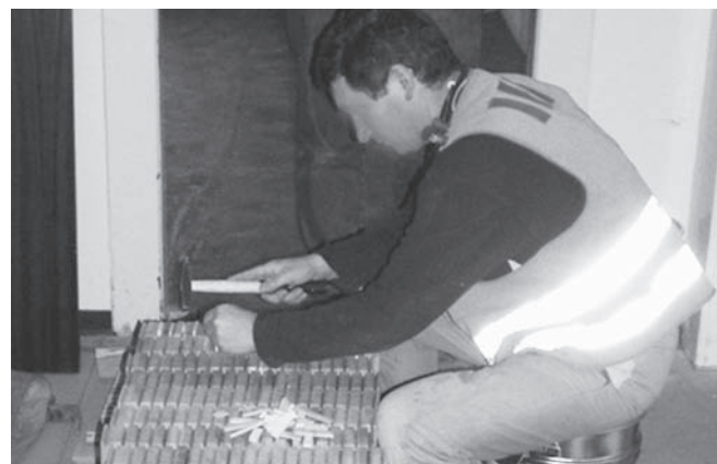
Abbildung B.9: Feder in das Massivholzparkett einschlagen
