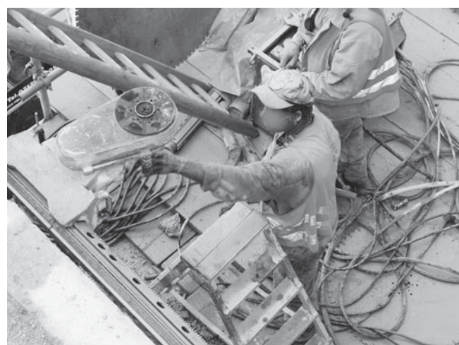
Abbildung D.10: Wandsäge umbauen
