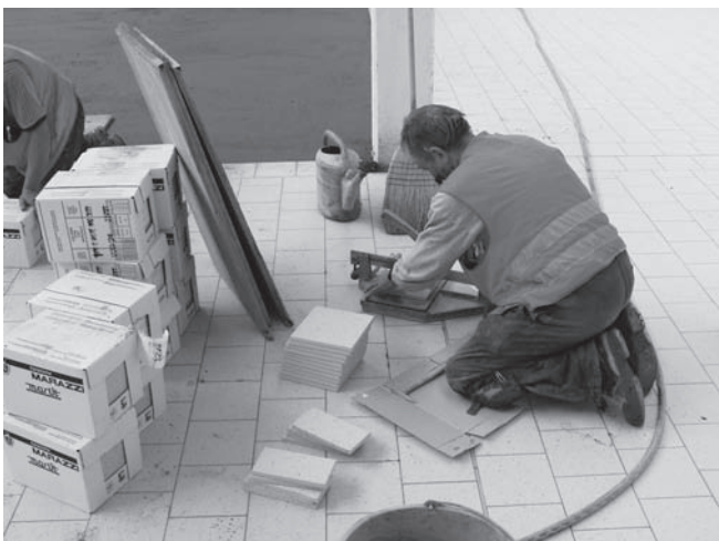
Abbildung A.32: Fliesen mit Fliesenbrett schneiden
