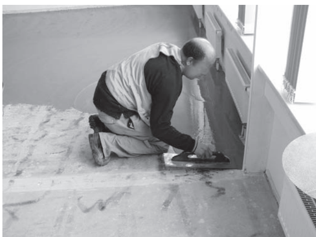
Abbildung C.15: Ausgleichsmasse auftragen
