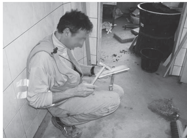
Abbildung A.10: Fliese mit Fliesenhammer bearbeiten
