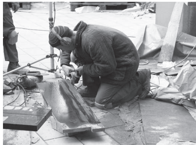
Abbildung A.42: Granitplatten mit Winkel-/Trennschleifer bearbeiten
