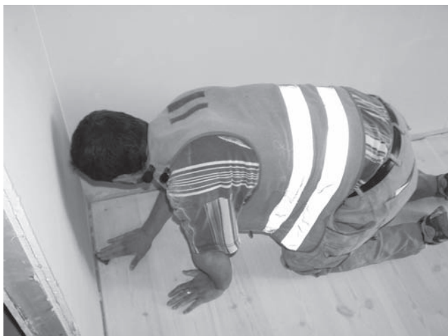
Abbildung B.16: Parkett mit Schleifpapier abschleifen
