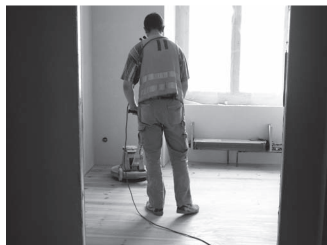
Abbildung B.15: Geöltes Parkett mit Einscheibengerät polieren
