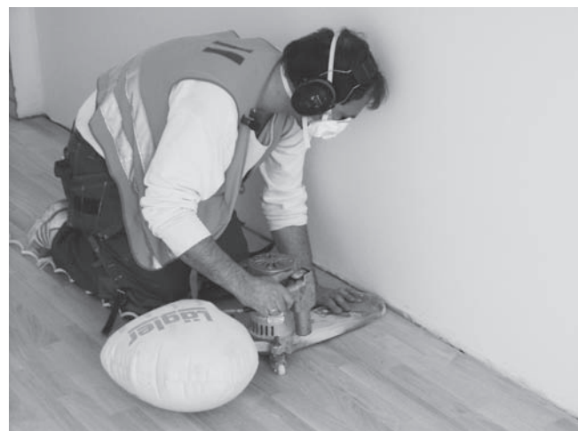
Abbildung B.21: Parkett mit Handschleifer abschleifen
