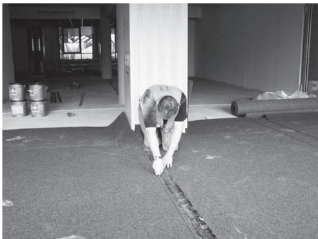
Abbildung C.24: Nadelfilz schneiden
