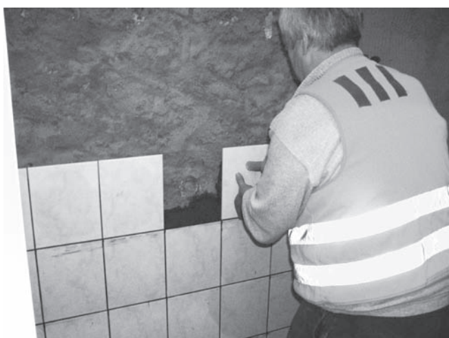
Abbildung A.11: Wandfliesen im Dickbettverfahren verlegen
