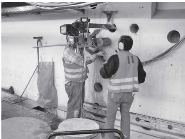
Abbildung D.16: Kernbohrgerät montieren
