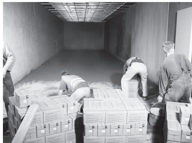
Abbildung A.31: Bodenfliesen verlegen
