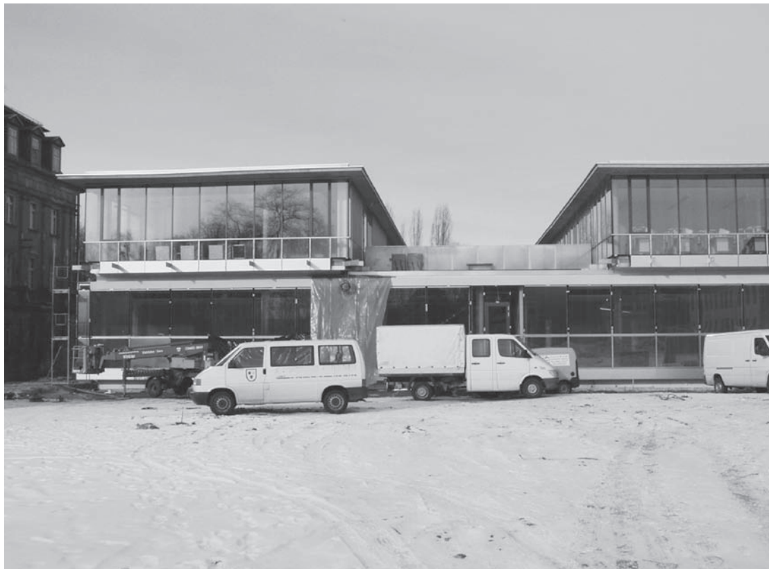
Abbildung A.7: Baustelle 13
