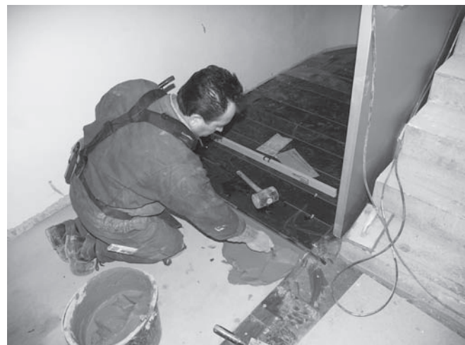
Abbildung A.46: Granitplatte kleben
