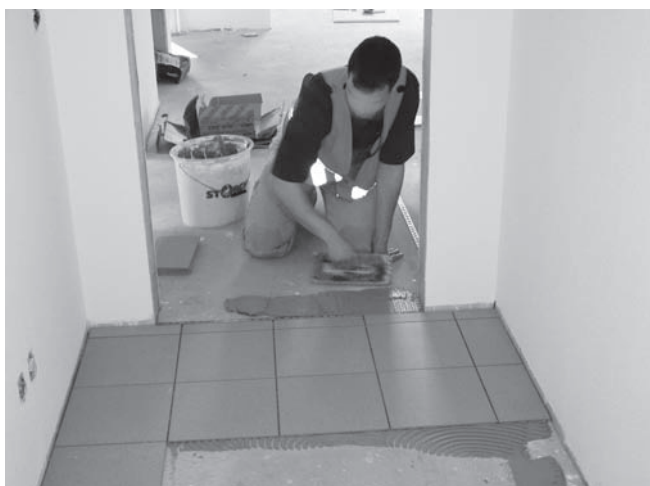
Abbildung A.23: Fliesenkleber auftragen
