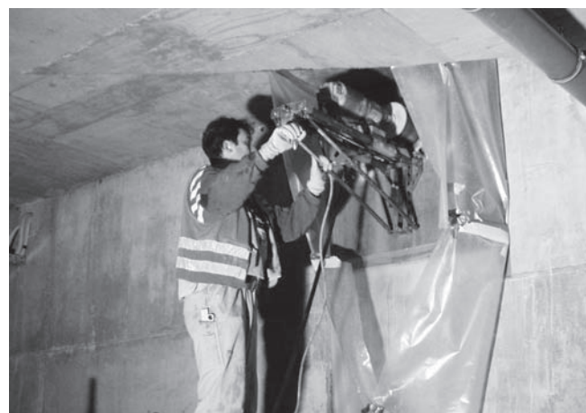
Abbildung D.24: Kernbohrgerät bedienen
