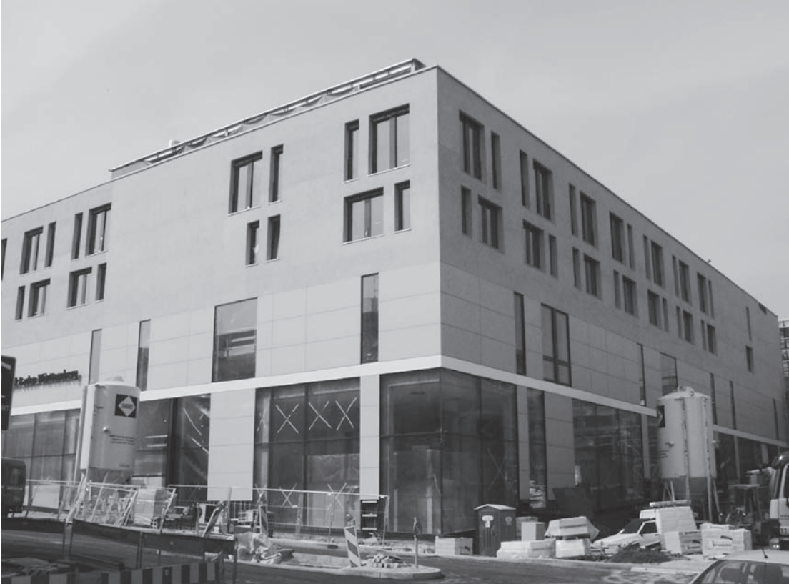
Abbildung A.8: Baustelle 15
