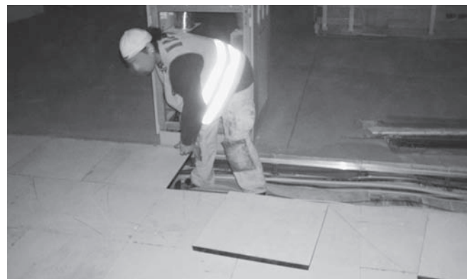
Abbildung C.23: Bodenplatten ausheben
