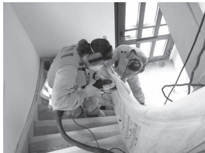
Abbildung B.24: Handlauf mit Schleifpapier abschleifen (Person rechts)
