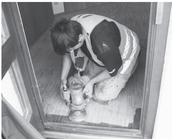
Abbildung B.20: Parkett mit Handschleifgerät abschleifen
