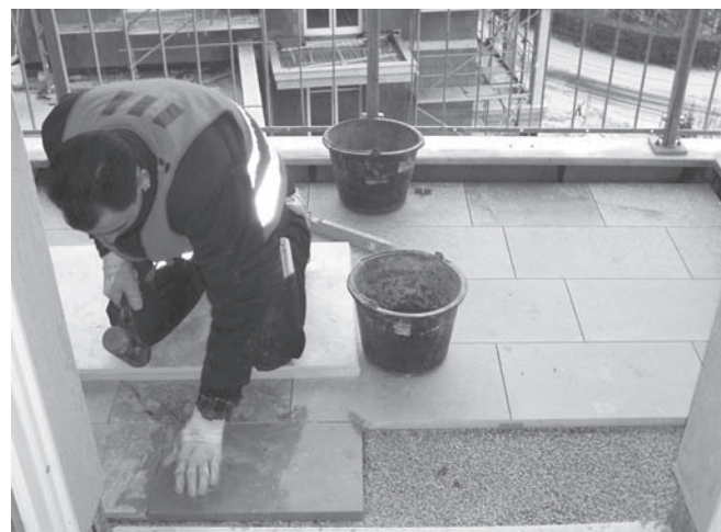
Abbildung A.38: Platten mit Gummihammer festsetzen
