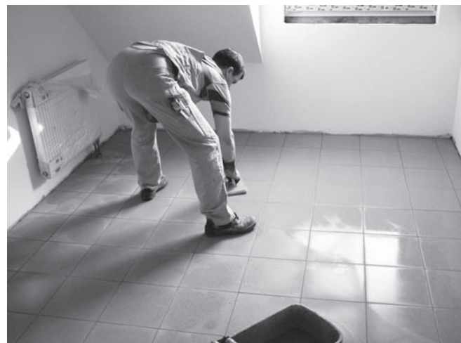
Abbildung A.26: Bodenfliesen verfugen
