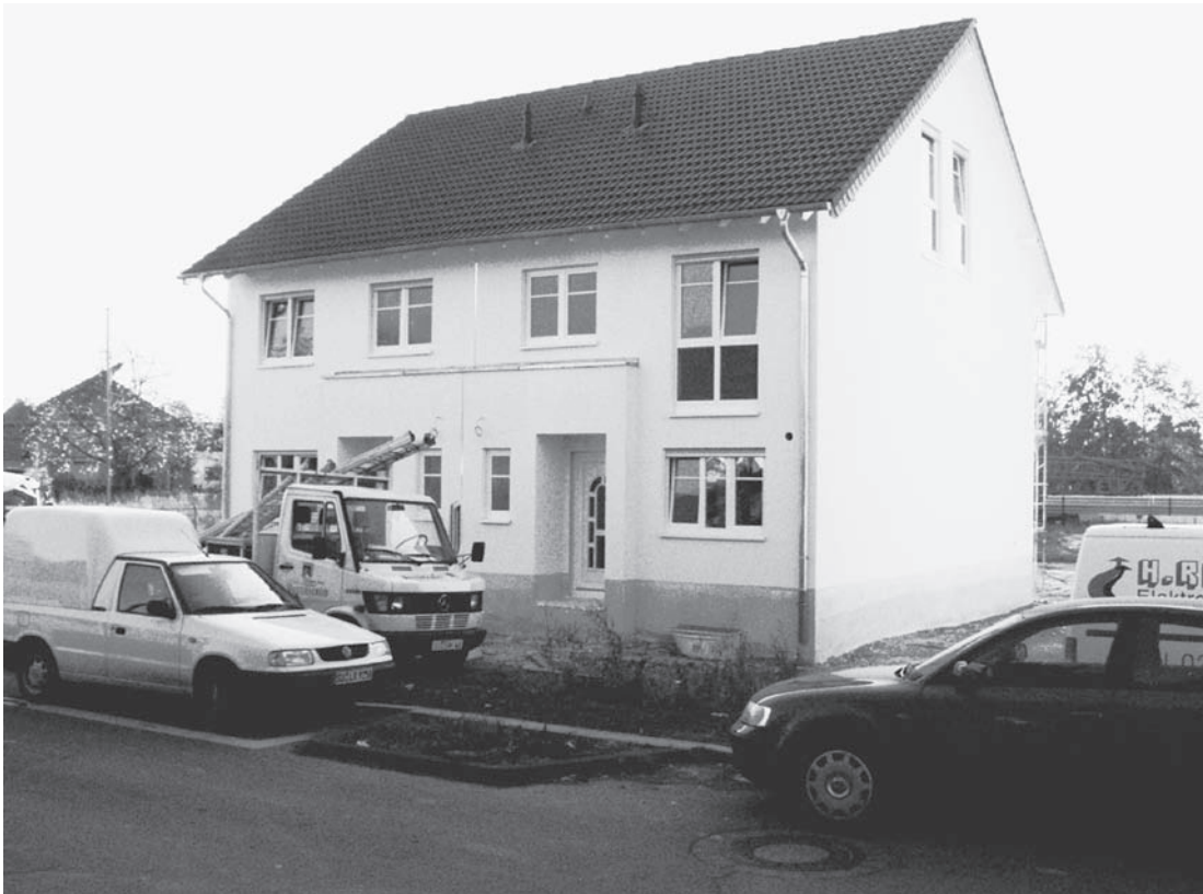
Abbildung A.2: Baustelle 3
