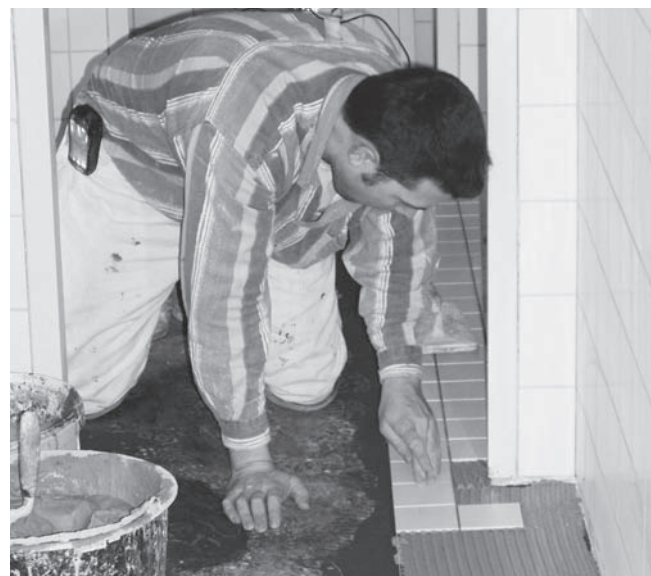
Abbildung A.20: Bodenfliesen verlegen
