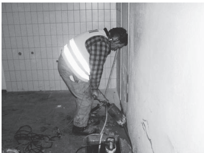
Abbildung D.31: Kernbohrung durch Mauerwerk
