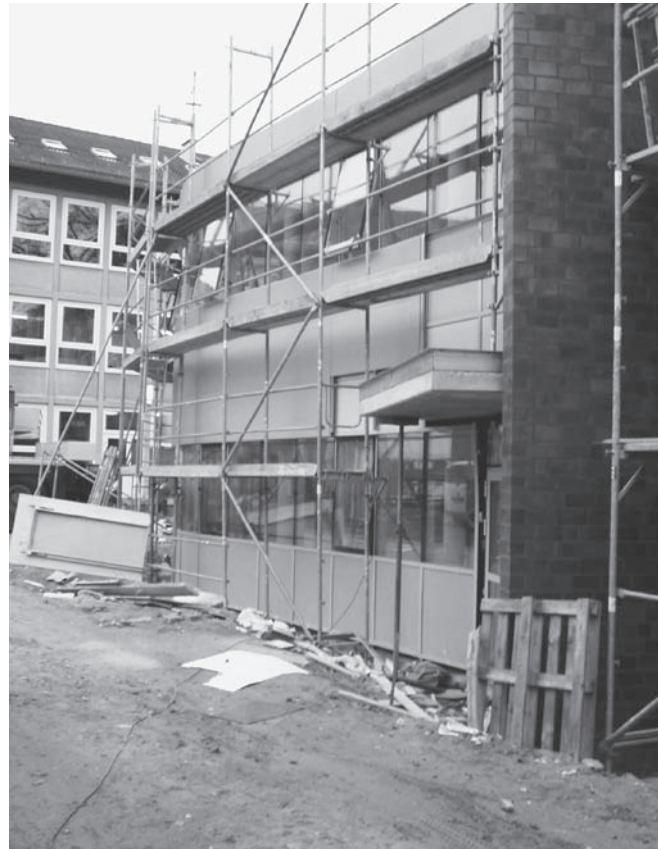
Abbildung A.3: Baustelle 4
