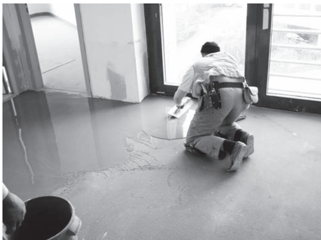
Abbildung C.8: Ausgleichsmasse auftragen
