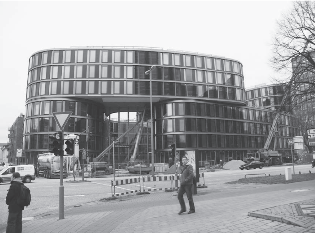
Abbildung A.9: Baustelle 16
