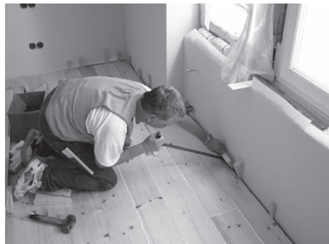
Abbildung B.14: Parkettdecken verlegen
