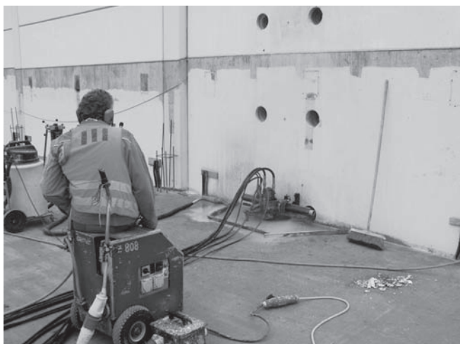
Abbildung D.25: Kernbohrgerät bedienen
