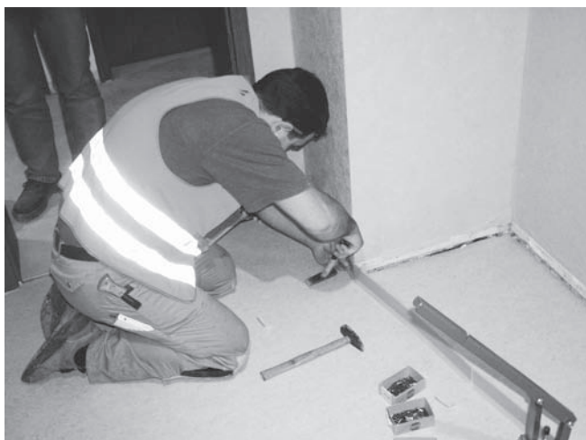
Abbildung C.9: Fußleiste festnageln
