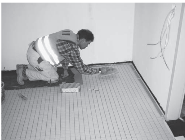
Abbildung A.15: Fliesen ausrichten und festsetzen
