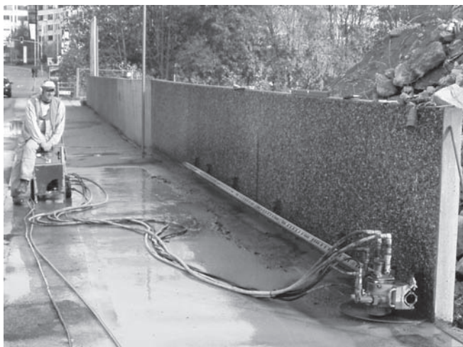
Abbildung D.23: Betonsäge bedienen
