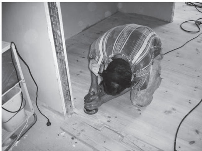
Abbildung B.13: Parkettboden mit Handschleifgerät abschleifen
