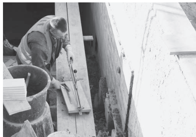
Abbildung A.12: Fliesen schneiden
