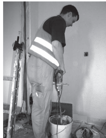
Abbildung A.24: Fliesenkleber anmischen
