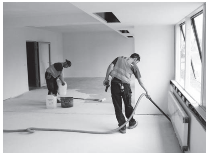
Abbildung C.19: Estrich mit Industriesauger absaugen
