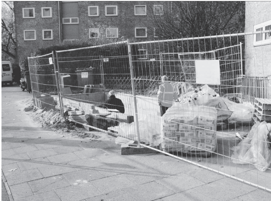
Abbildung A.1: Baustelle 2
