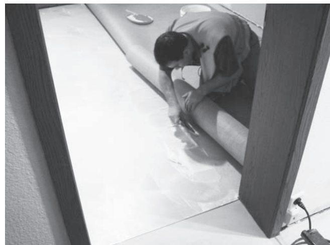
Abbildung C.10: Linoleum verlegen
