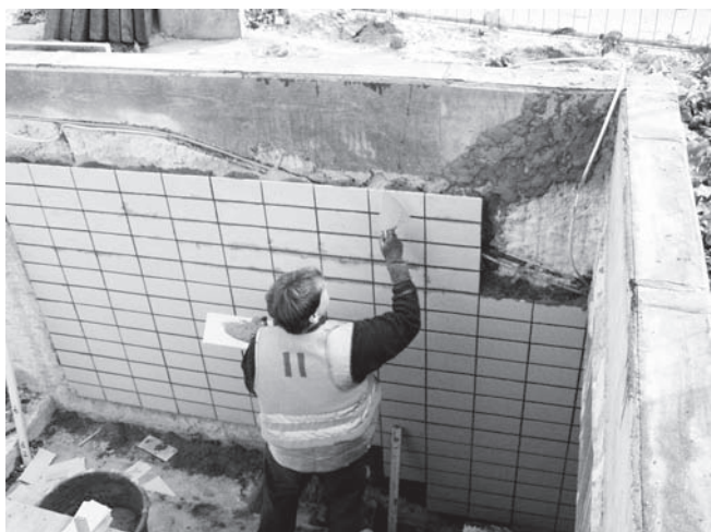
Abbildung A.13: Fliesen im Dickbettverfahren verlegen
