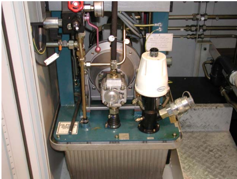
Abbildung 42: Öltank mit eingebautem Rücklauf-Belüftungs-Filter und zusätzlichem Schnellkupplungsanschluss
