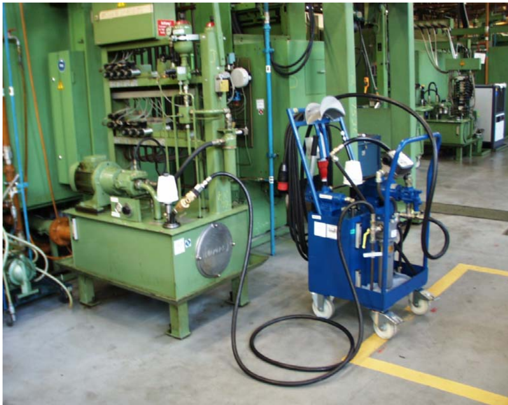
Abbildung 44: Neubefüllung einer Anlage mit einem Befüllungswagen über eine Schnellkupplung; Quelle: Instandhaltungsabteilung Anwender A
