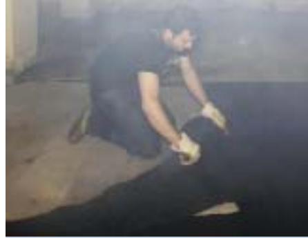
Arbeiter bei der Heißverarbeitung von Bitumen (Foto Dr. Schott, BauBG)
