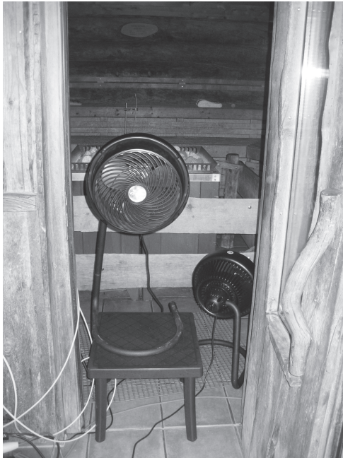
Bild 2. Lüftung der Saunaräume.
