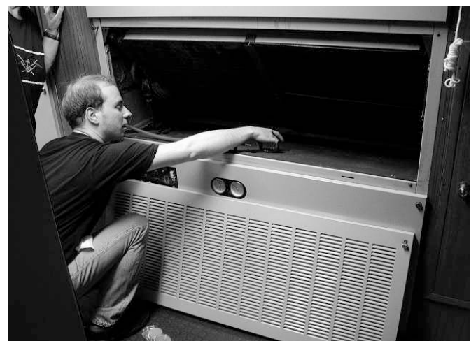
Bild 4. Abklatschuntersuchung in der Klimabox des Maschinenkontrollraums.
