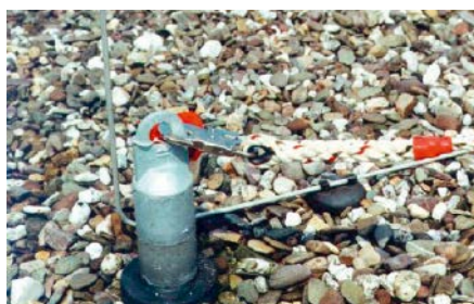
Abb. 2: Dauerhaft befestigte Anschlageneinrichtung mit einem Einzelanschlagpunkt (Sekurant)
