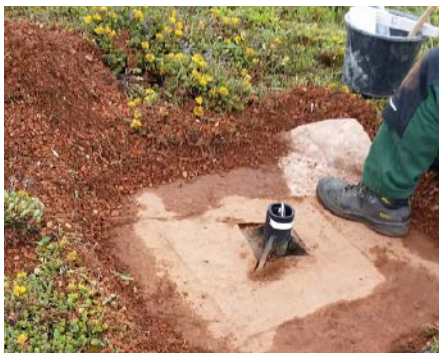
Abb. 7: Auflastgehaltene Anschlageinrichtung auf einem Gründach (zur Überprüfung freigelegt)
