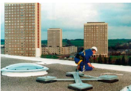
Abb. 1: Anschlageneinrichtung Typ E (PSAgA)
