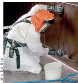
Foto: BG Bau
