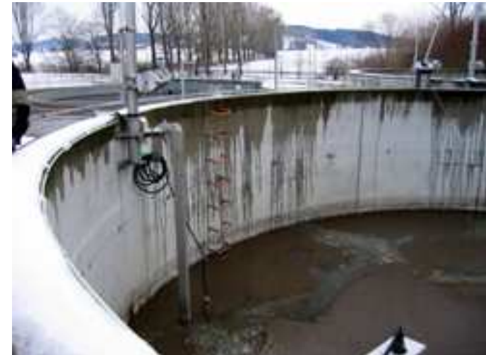
Labor in einer Kläranlage
