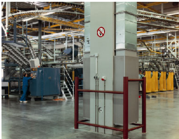
Abbildung 10: Anordnung der Quellluftdurchlässe
