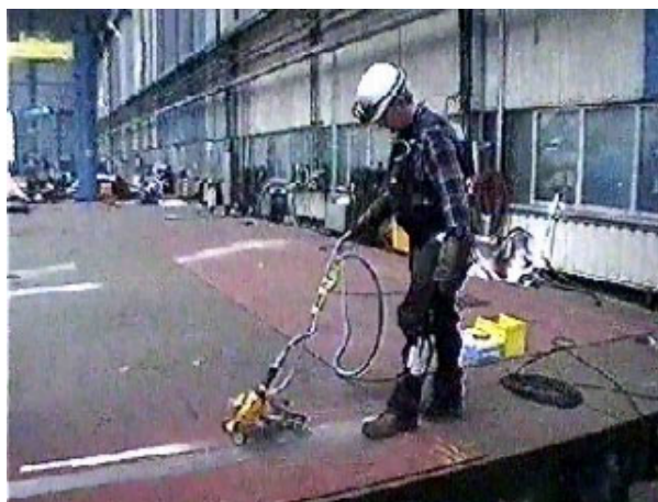
Abbildung 2: Schweißnahtvorbereitung mit Turbo-Bandschleifer
