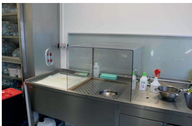
Bild Im IFA hergestellte Erfassungshaube über der Lochblechabsaugung eines Pathologisches. Foto: W. Wegscheider
